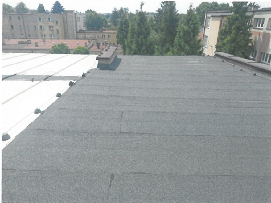
Fot. 5. Widok dachu od strony północnej
