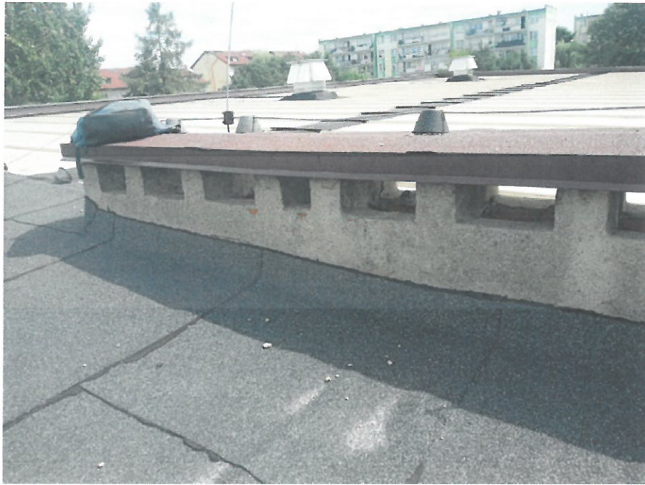
Fot. 8. Komin wentylacyjny – murowany
