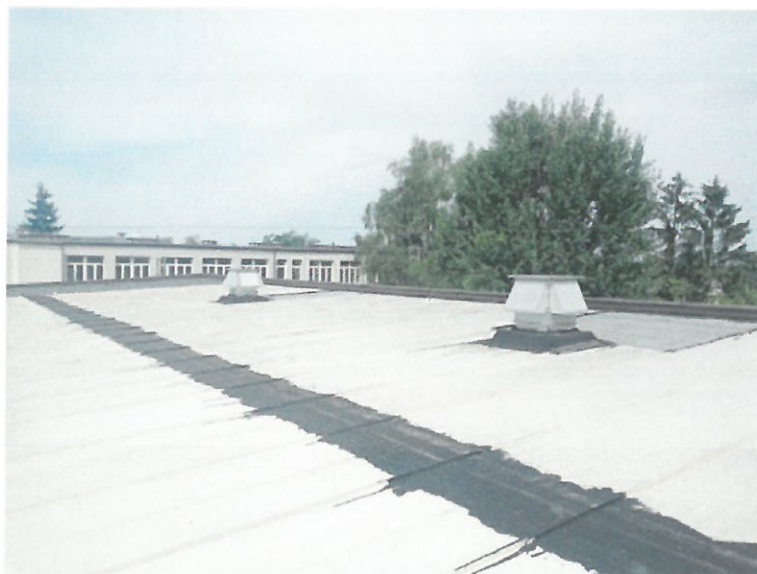
Fot. 2. Ogólny widok dachu od strony południowo wschodniej
