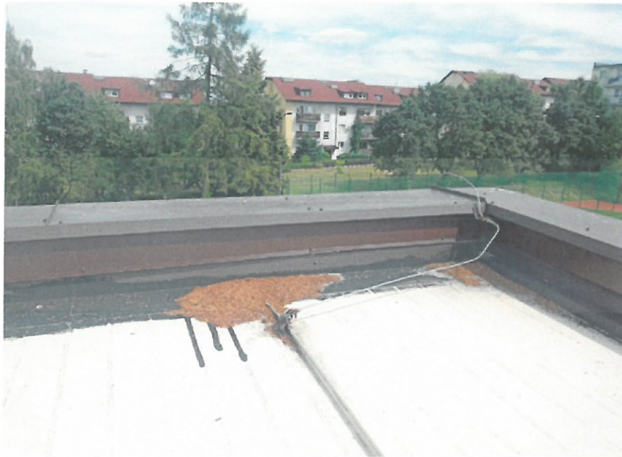
Fot. 6. Obróbki blacharskie
