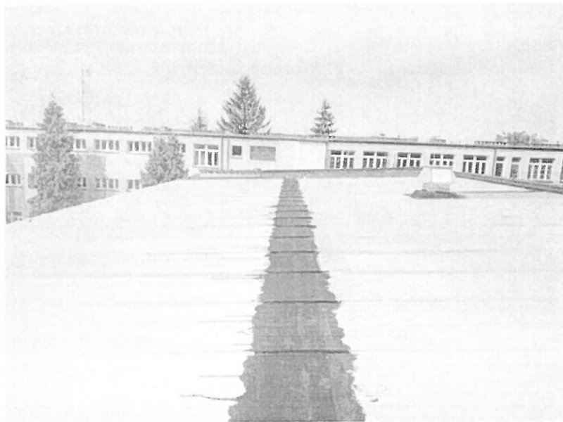
Fot. 1. Ogólny widok dachu od strony wschodniej
