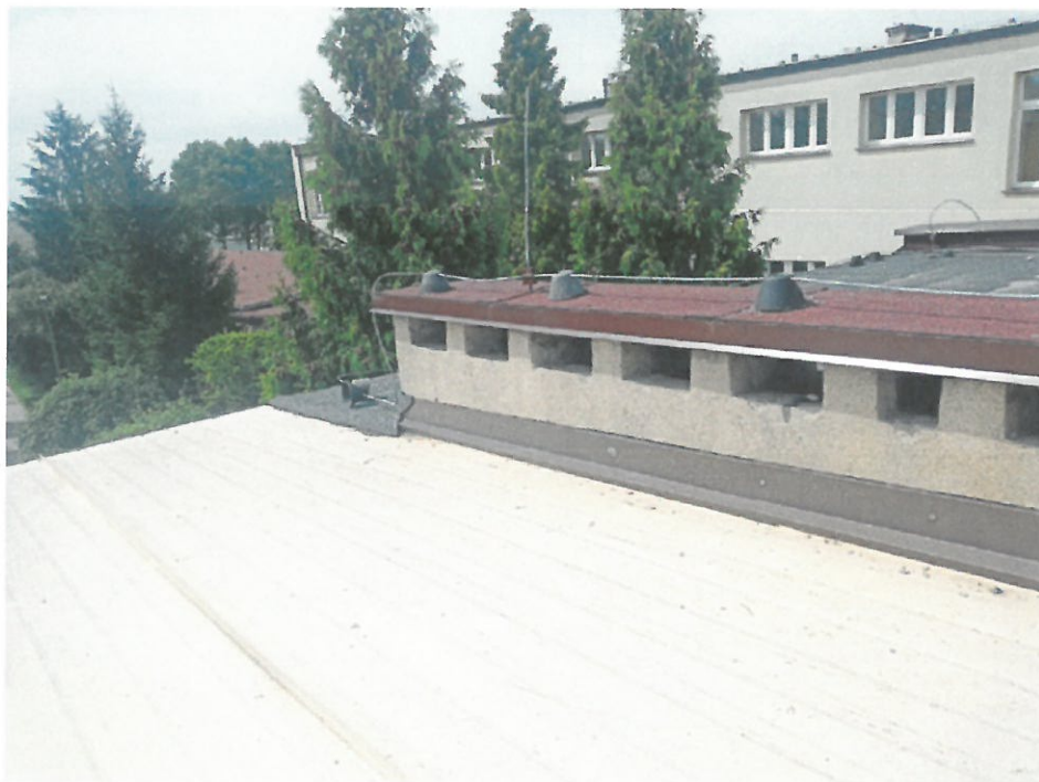
Fot. 7. Komin wentylacyjny – murowany
