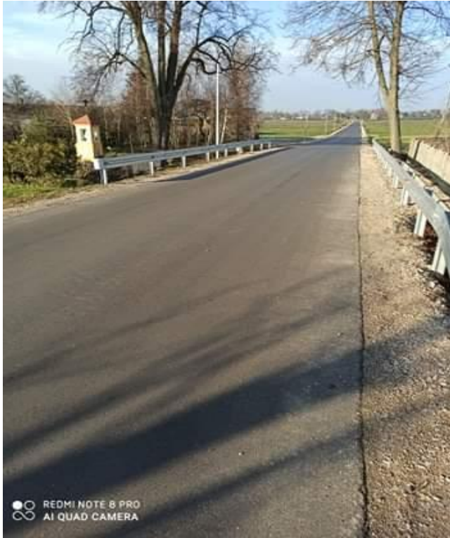
Foto 11. Droga powiatowa Nr 2934 E w miejscowości Popień po przebudowie
