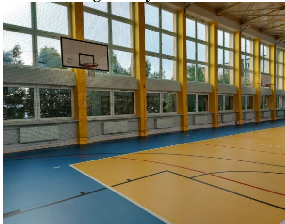
Foto 15. Sala gimnastyczna w ZSP w Brzezinach po modernizacji
